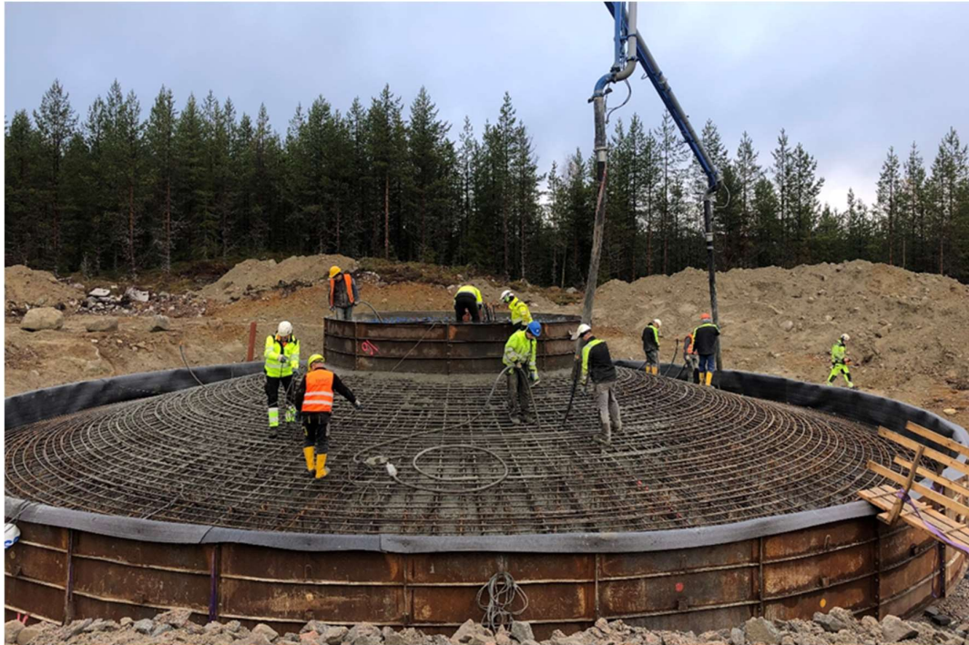
FIGUR 4-4: BYGGNATION AV GRAVITATIONSFUNDAMENT VID VINDKRAFTSPARK BLÅBERGLIDEN. HÄR SYNS DEL AV ARMERINGEN UNDER PÅGÅENDE BETONGGJUTNING.
