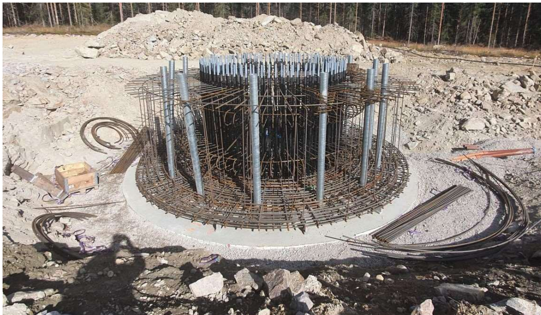
FIGUR 4-5: BYGGNATION AV BERGSFÖRANKRAT FUNDAMENT VID VINDKRAFTSPARK BLÅBERGSLIDEN.
